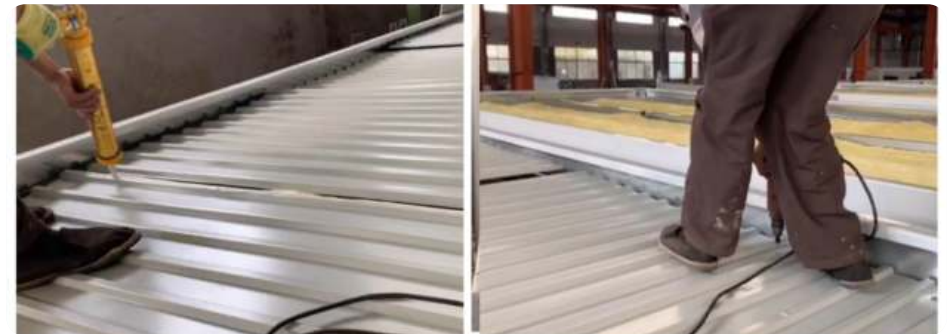
Cubierta de chapa con sellador en el solape
